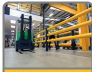
Odvajanje pešačke zone
