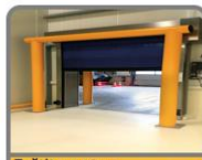
Zaštita vrata-označavanje visine prolaza
